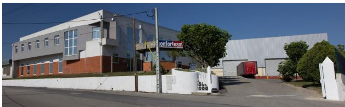
Fig 6 - Fachada da empresa
