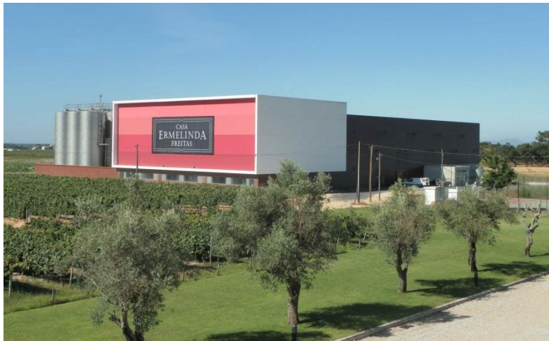
Fig. 7 - Edifício Casa Ermelinda Freitas.
