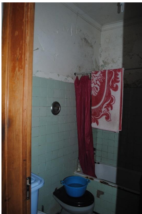
Figura 11 - WC antes da intervenção. Fotografia de: Ângela Silva
