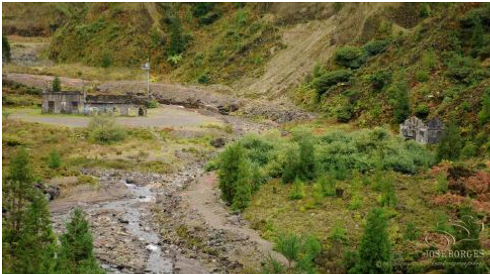
Figura 1.- Vista aérea do vale das Lombadas- Na esquerda encontra-se a antiga fábrica de engarrafamento das águas e do lado direito, a actual nascente que corre no interior do edifício em ruína.
