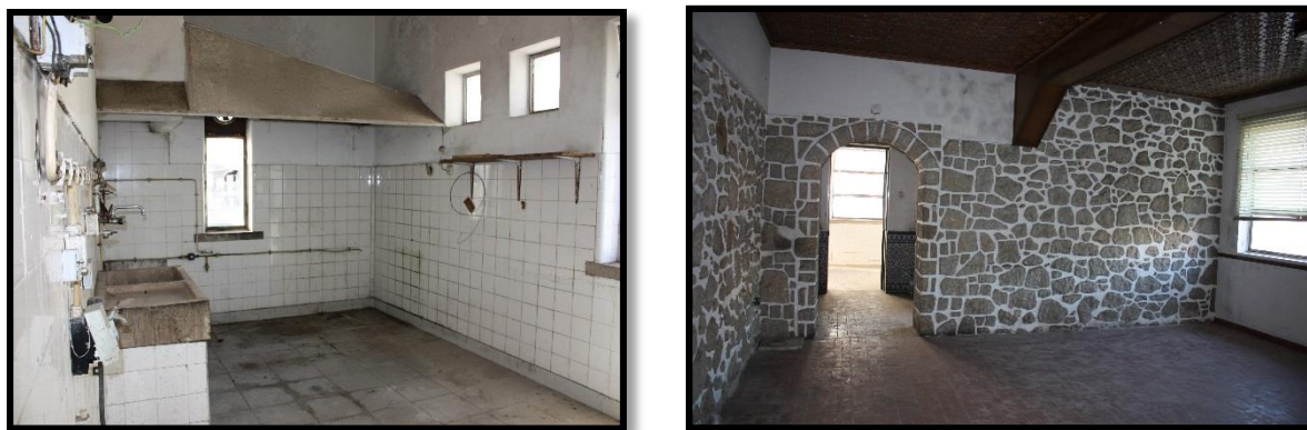
Figuras 4 e 5 Cozinha e Sala de Refeições Antiga Guarda Fiscal de Castelo Branco
