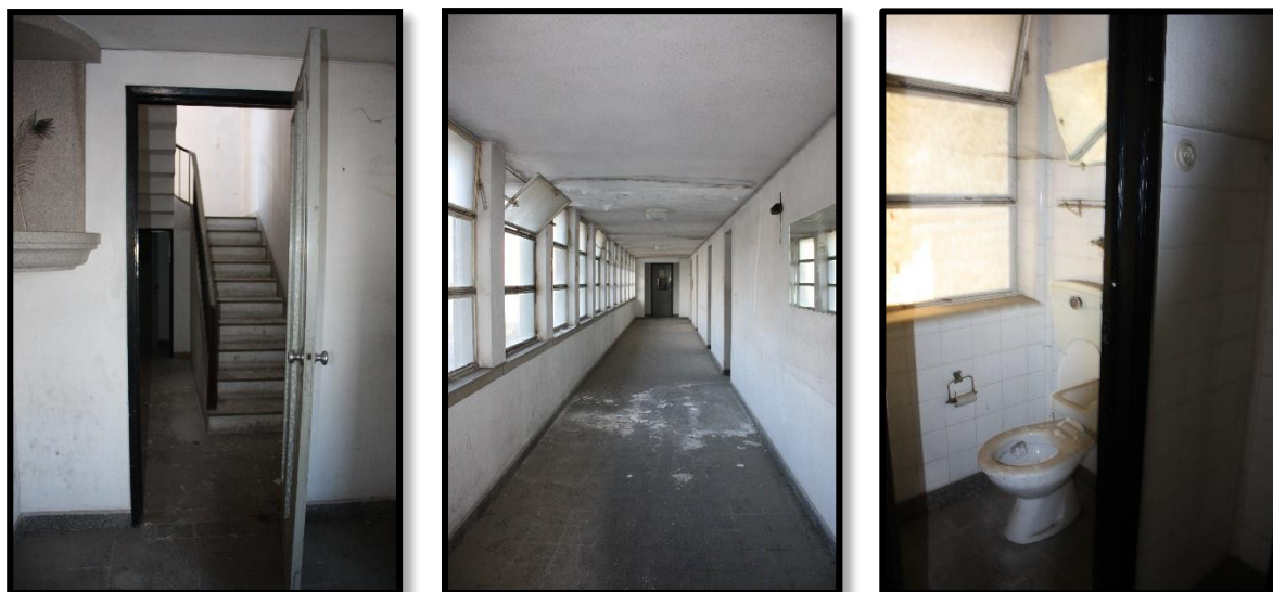
Figuras 1, 2 e 3 Escadas, Corredor e Casa de Banho Antiga Guarda Fiscal de Castelo Branco
