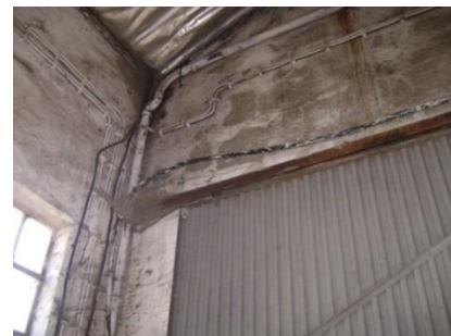
Ilustração 19: Infiltrações telhado
