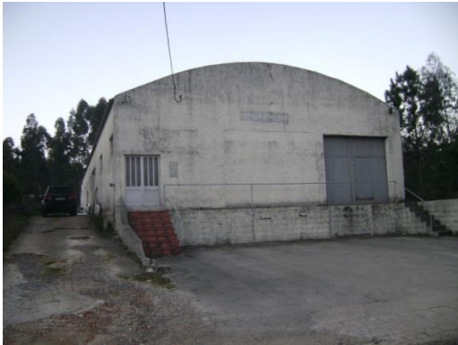
Ilustração 5: Fotografia da entrada do pavilhão
