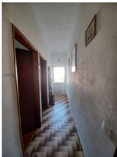
Figura 12 Corredor principal / vista da entrada
