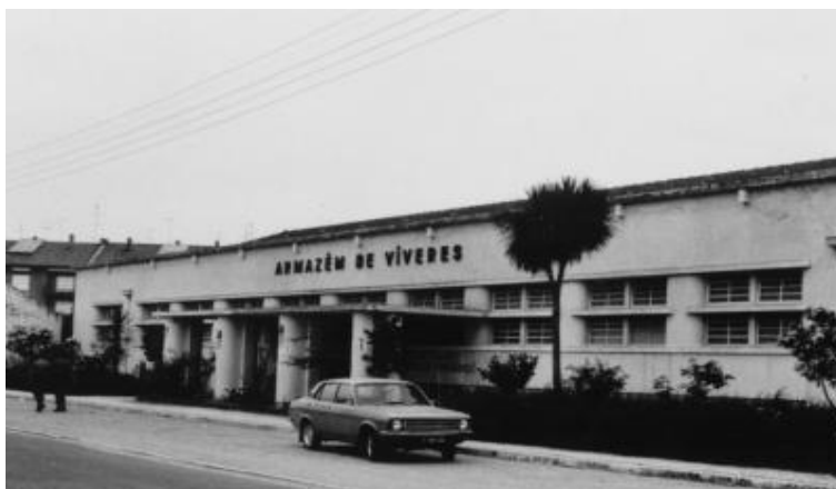
Figura 4- Armazém de víveres. Fonte: Câmara Municipal do Entroncamento.
