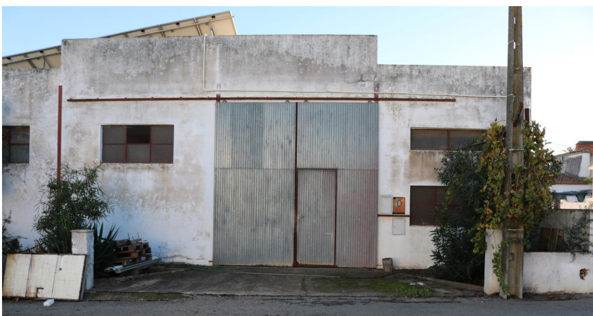
Figura 10 - Fotografia Alçado Principal (Norte). Fonte: (Autor)
