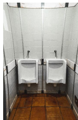
Figura 12 - Casas de Banho masculina - Sala de Refeições
