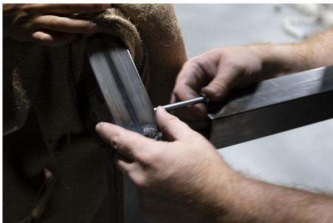
Fig Colocação de parafusos nos pontos de fixação
