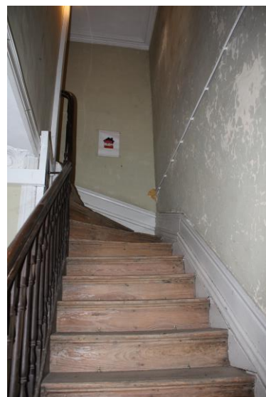
Figura 23 –Escadas de acesso ao piso 1; ano 2021; Fonte: Ana Ferreira
