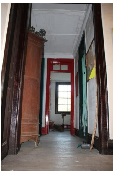
Figura 36 – Hall das salas do piso 2; ano 2021; Fonte: Ana Ferreira
