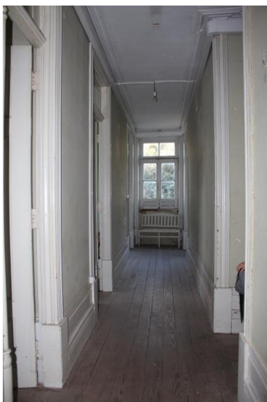
Figura 24 –Corredor principal piso 1; ano 2021; Fonte: Ana Ferreira
