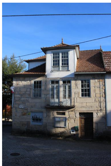
Figura 11 — Fachada Principal Oeste; ano 2021; Fonte: Ana Ferreira
