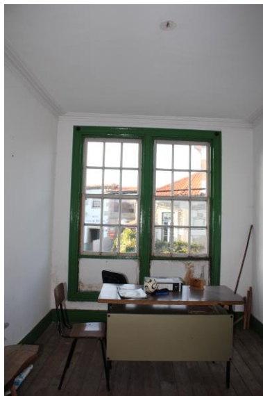
Figura 39 – Sala 7, situada na fachada Oeste; ano 2021; Fonte: Ana Ferreira
