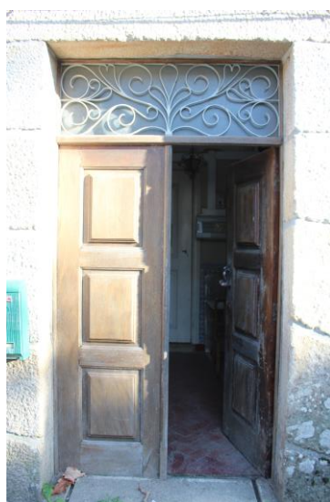
Figura 12 — Porta de Entrada Principal; ano 2021; Fonte: Ana Ferreira
