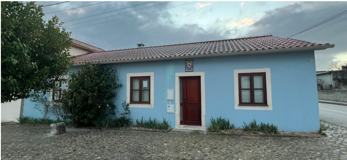
Figura 1 – Fachada da frente da moradia. | Fotografia de Autor
