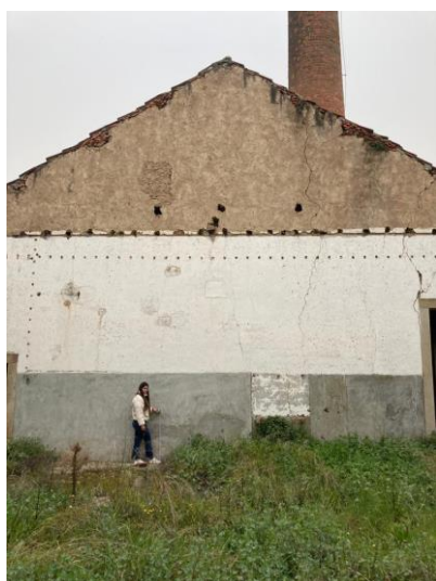
Figura 7 - Medição do edifício. (fotografia de autor)
