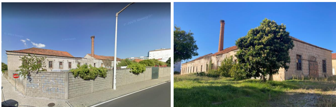
Figura 13 - Entrada do edifício e vista do exterior (fonte: Google maps)
