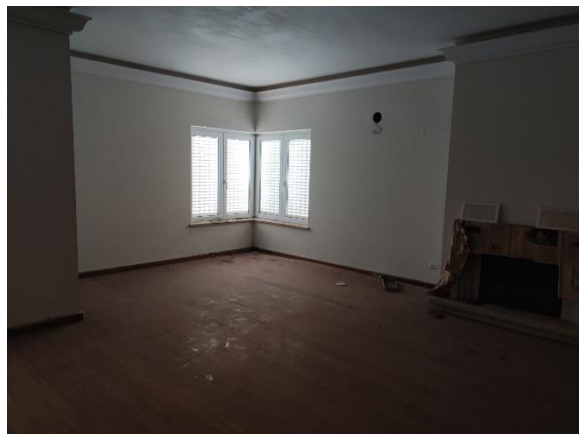
Figura 20- Piso 0, Zona de Estar
