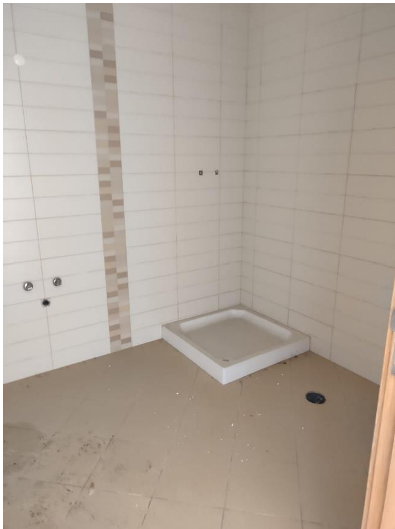
Figura 19- Piso 0, Casa de Banho
