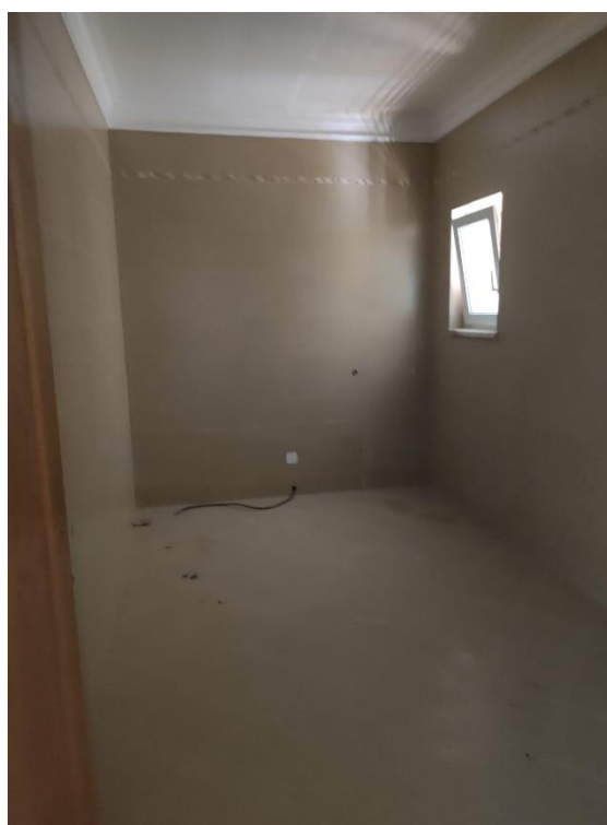
Figura 29- Piso 1, Casa de Banho
