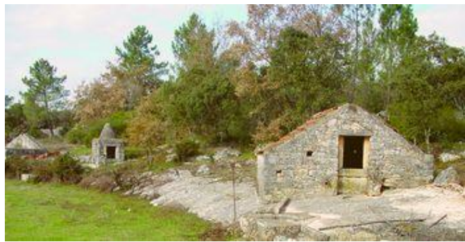
Figura 55 - Casas cisterna, Casalinho Farto. Autor: Geocaching.
