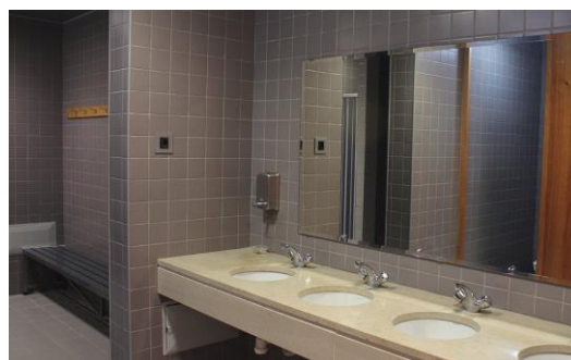
Figura 65 - Instalações sanitárias. Fonte: Centro de Ciência Viva do Alviela.
