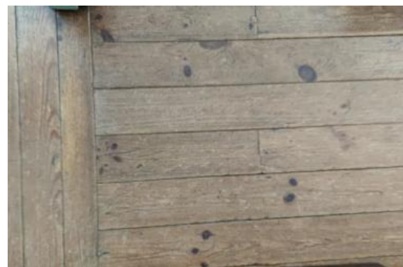
Figura 22 - Pormenor pavimento Piso 1. Foto de Autor, 2022
