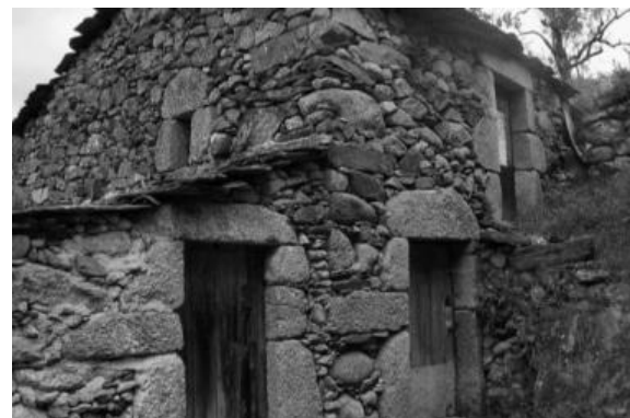
Figura 13 - Casa típica de Loriga em granito. Foto de Paulo Juntas. Fonte: Wikipédia
