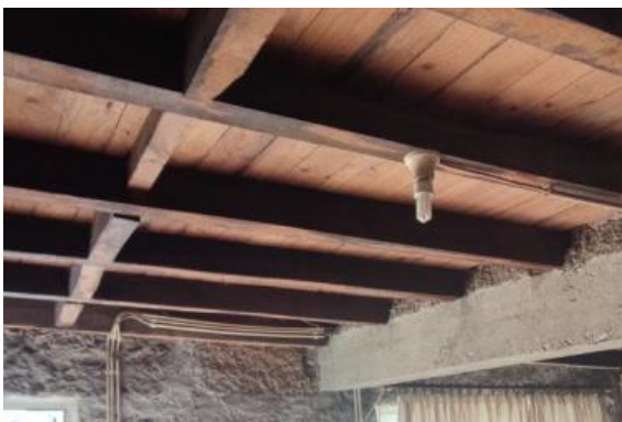
Figura 21 - Pormenor estrutura. Foto de Autor, 2022
