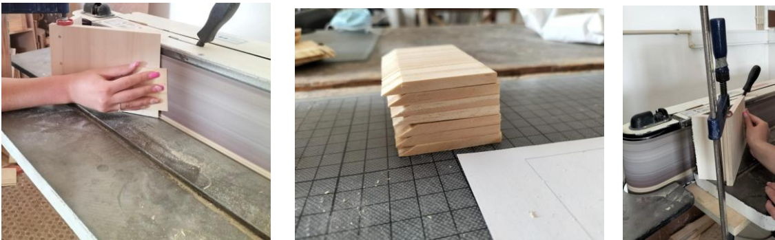
Figuras 82,83 e 84 – Imagens do Processo de Execução em Oficina, Execução das Peças Interiores e os respectivos ângulos, Fonte: Autor
