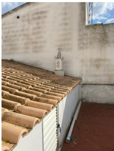
Figura 15 – Zona do Telhado e acesso ao Sótão
