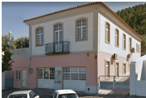
Fig. 6 Fachada do edifício
