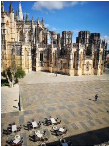
Figura 56 - Batalha, Edifício Mouzinho de Albuquerque, 3º piso, vista do exterior
