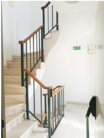
Figura 32 - Batalha, Edifício Mouzinho de Albuquerque, escadas de acesso ao 2º piso
