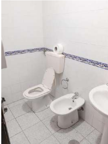
Figura 19 - Batalha, Edifício Mouzinho de Albuquerque, piso 0, instalação sanitária 1
