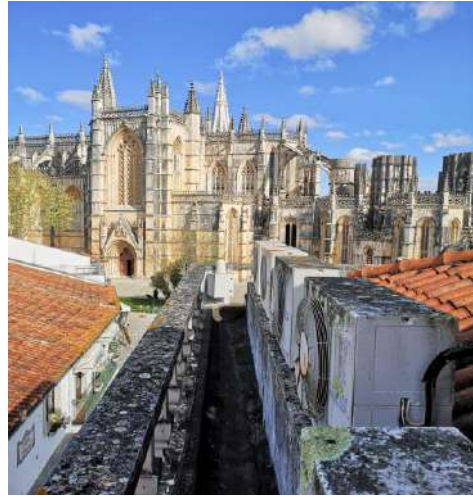
Figura 55 - Batalha, Edifício Mouzinho de Albuquerque, 3º piso, vista do exterior
