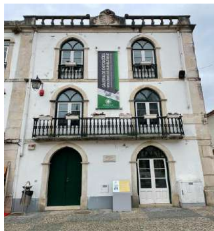
Figura 7 - Batalha, Edifício Mouzinho de Albuquerque, alçado principal
