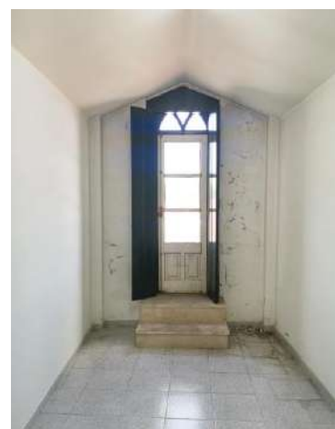
Figura 53 - Batalha, Edifício Mouzinho de Albuquerque, 3º piso, porta de acesso ao exterior
