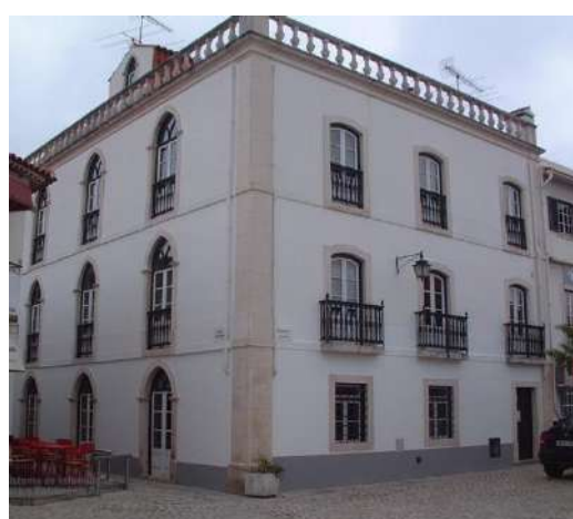
Figura 9 - Batalha, Edifício Mouzinho de Albuquerque, alçado lateral direito e posterior
