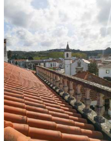
Figura 58 - Batalha, Edifício Mouzinho de Albuquerque, 3º piso, vista do exterior
