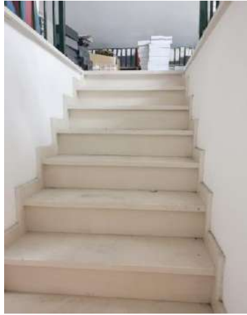
Figura 47 - Batalha, Edifício Mouzinho de Albuquerque, escadas de acesso ao 3º piso
