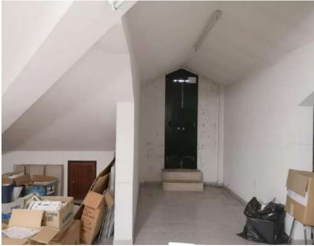
Figura 54 - Batalha, Edifício Mouzinho de Albuquerque, 3º piso, porta de acesso ao exterior
