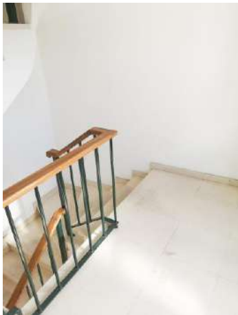
Figura 23 - Batalha, Edifício Mouzinho de Albuquerque, escadas principais de acesso ao 1º piso
