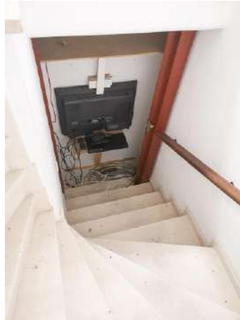
Figura 29 - Batalha, Edifício Mouzinho de Albuquerque, escadas nº2 de acesso ao 1º piso
