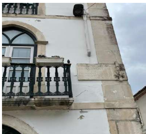
Figura 8 - Batalha, Edifício Mouzinho de Albuquerque, alçado principal, pormenor da lápide toponímica
