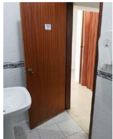
Figura 43 - Batalha, Edifício Mouzinho de Albuquerque, 2º piso, instalação sanitária
