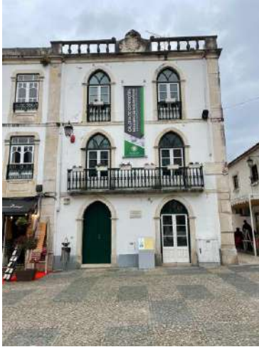
Figura 4 - Batalha, Edifício Mouzinho de Albuquerque, alçado principal, fonte: autora
