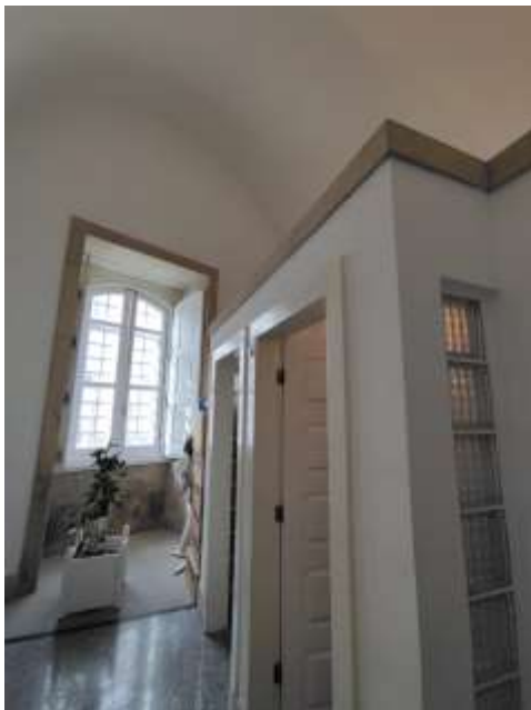
Figura 16. Almeida, Paços do Concelho, Instalações sanitárias Fonte: Arquiteto Luís Trindade
