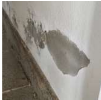
Figura 33. Instalações sanitárias, salitre
