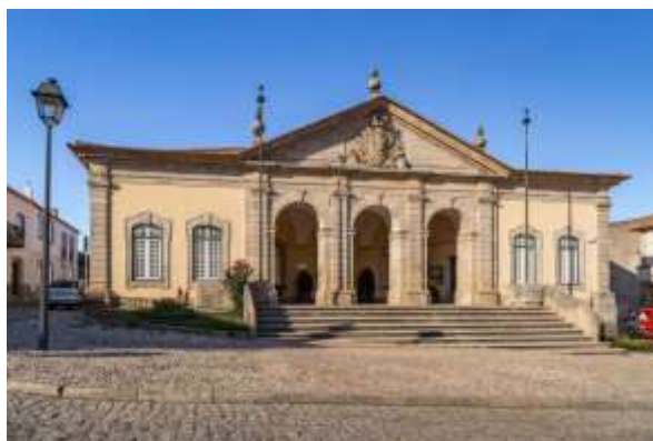
Figura 6. Fachada do edifício do Corpo da Guarda Fonte: Município de Almeida
