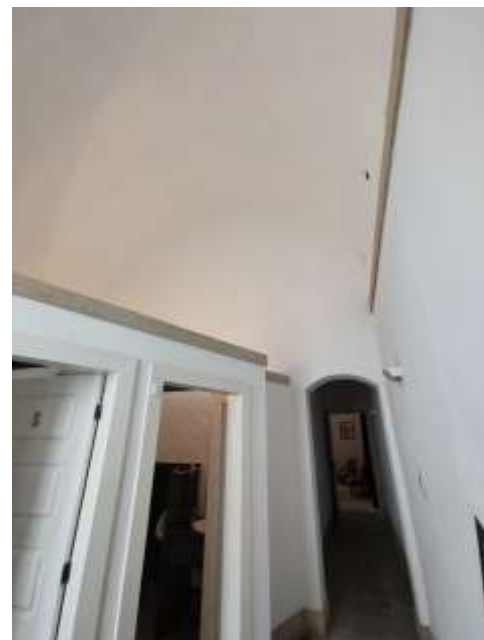
Figura 17. Almeida, Paços do Concelho, Instalações sanitárias Fonte: Arquiteto Luís Trindade
