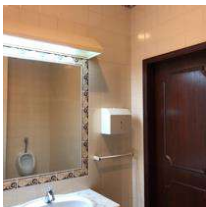
Figura 29 - Fotografia das Instalações Sanitárias Comuns Masculinas 2
