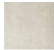
Figura 45 - Pavimento das instalações sanitárias
