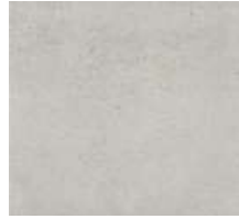
Figura 43 - Pavimento da sala de refeições
