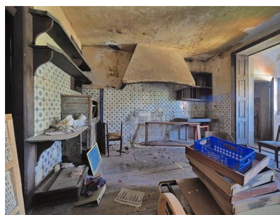
Figura 20. Cozinha Divisão do terceiro andar espaço total
