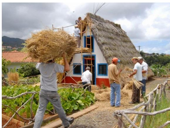
**Figura 11** – Montagem do colmo;
