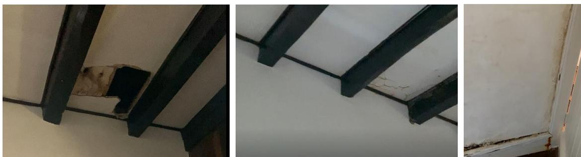
Figura 34 – Piso 0, zona de estar, degradação e patologias devido a infiltrações de água e humidades, ano de 2021.
