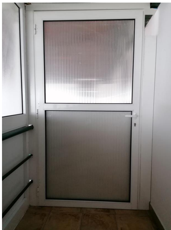
Figura 3 - Porta de Alumínio (Fonte Autora)
