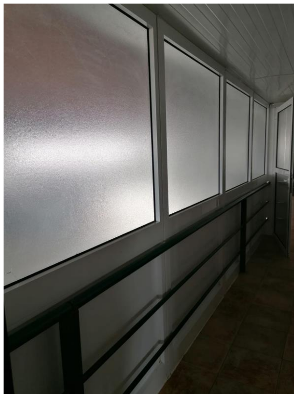
Figura 5 - Marquise de Alumínio (Fonte Autora)
