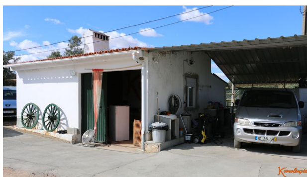
Figura 1 - Instalações da Komolimpia - Julho 2021; Fonte: (Autor)
