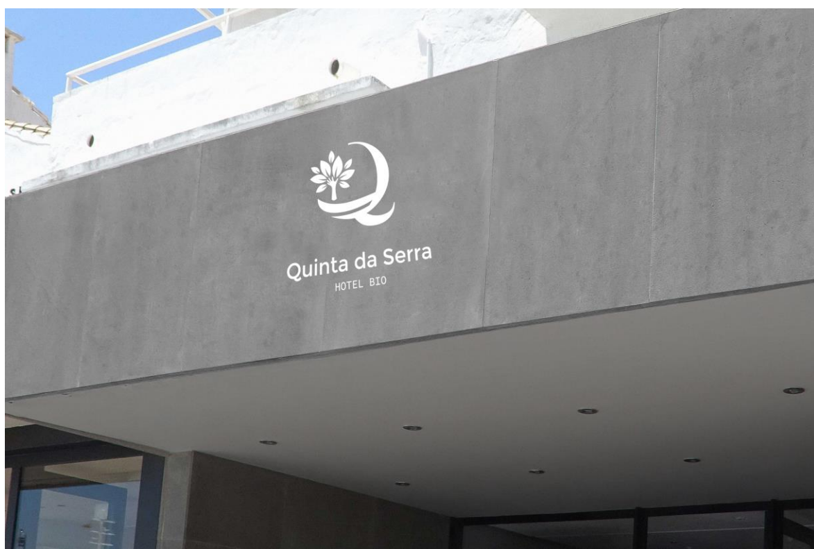
Figura 99 - Fachada (Fonte Autora 2020)
