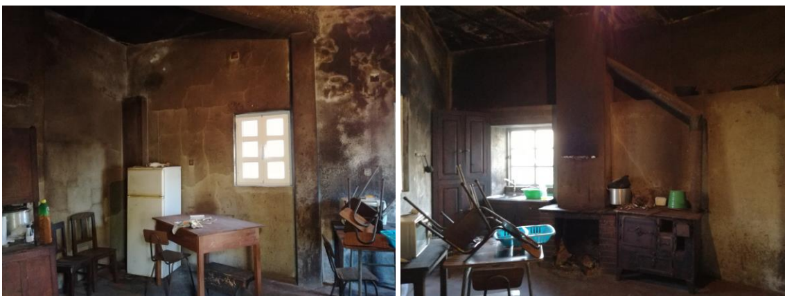
Figura 23 - Fotografias do espaço interior do anexo
