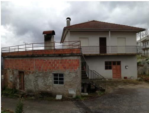
Figura 10 - Fotografia do alçado principal
