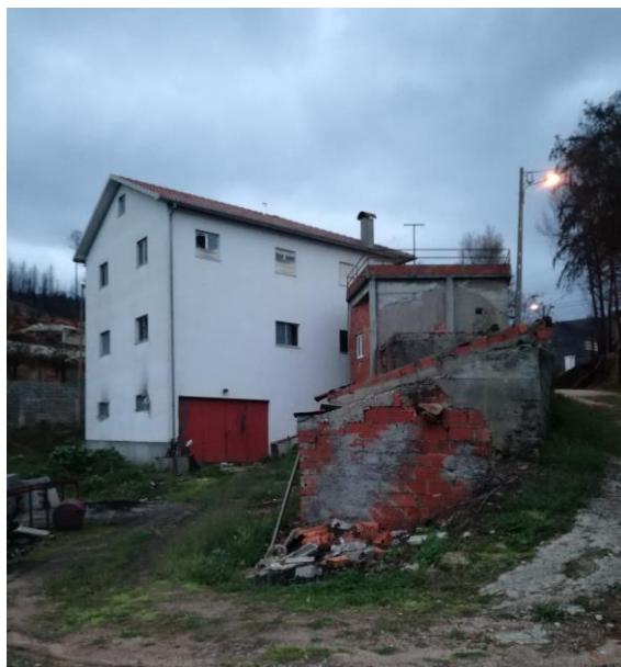
Figura 24 - Fotografia do alçado lateral esquerdo
