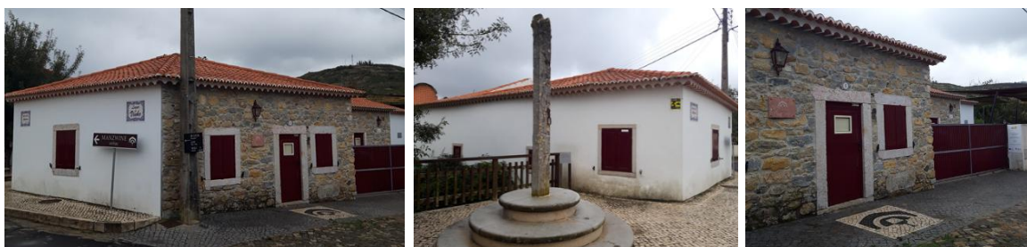
Figura 4, Fachada do edifício atualmente
