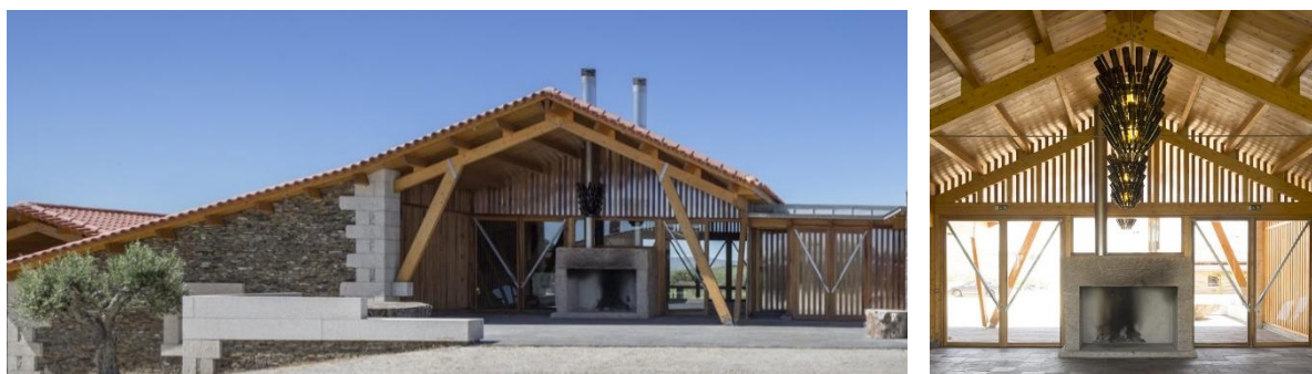
Figura 7, Fachada do edifício e uma das salas interiores. fonte: https://www.carloscastanheira.pt/project/quinta-da-faisca-winery/#drawings
