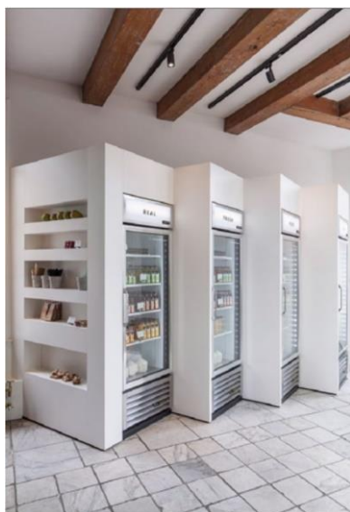
Figura 6. Vista Detalhada das Vitruines de Refrigeração
