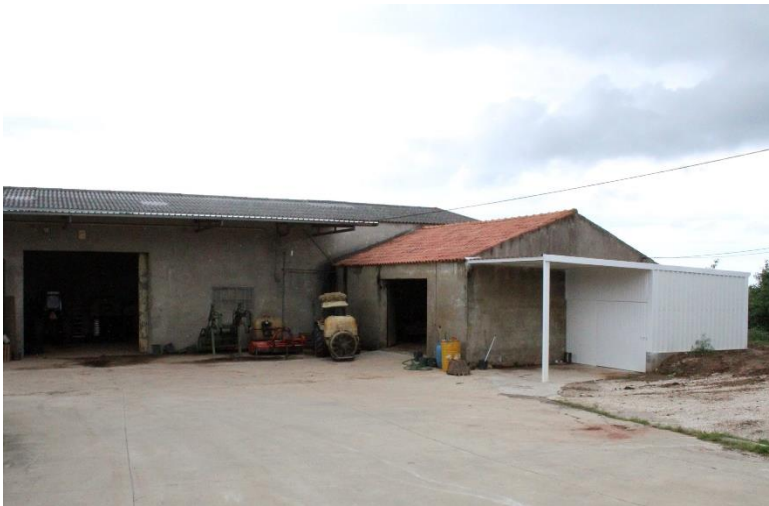
Figura 35. Vista Exterior dos Armazéns
