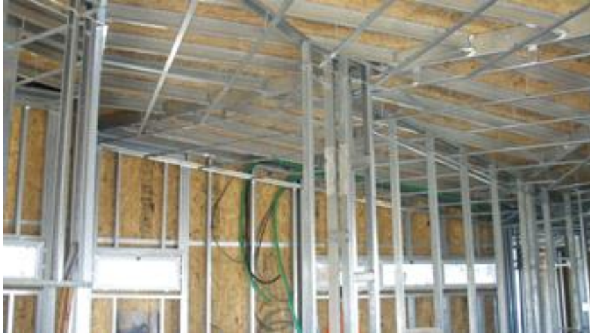
Figura 11 – Sistema de construção de paredes e tetos
