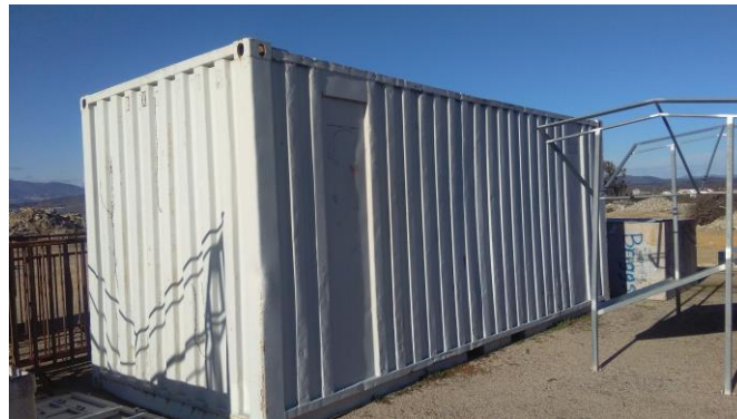
Figura 3 – Exterior do contentor marítimo (6.00 comp x 2.50 larg x 2.70 alt)
