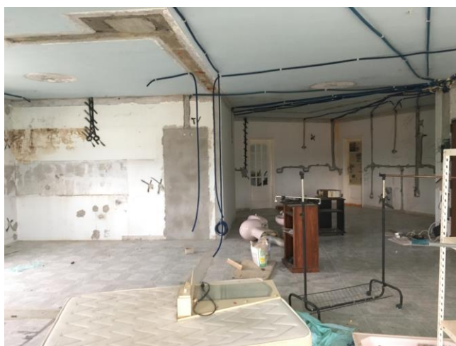
Figura 6 e 7- Espaço em Obras
