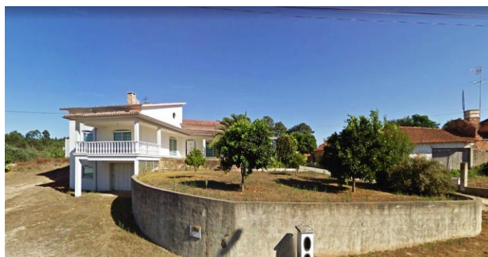
Figura 2 – Vista exterior da habitação (frente)
