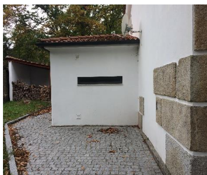
FIG.3 – Traseiras do edifício
