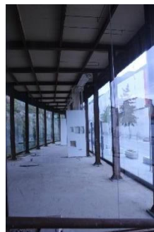
Figura 26 - Fotografia do interior do edifício
