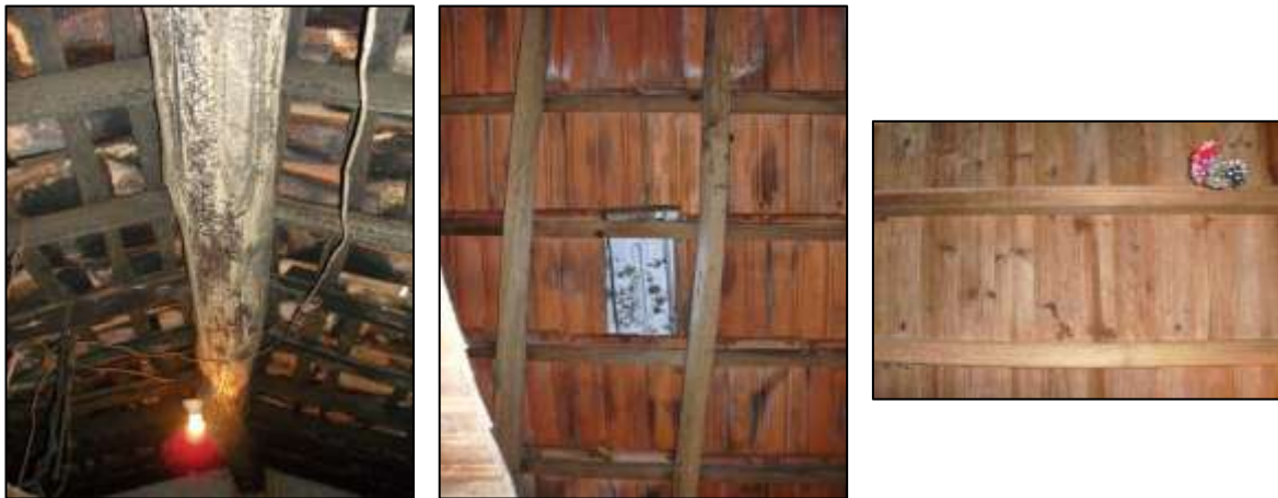
Figura 1 - Pormenor do Telhado. Pormenor do teto do quarto e da casa de banho.
