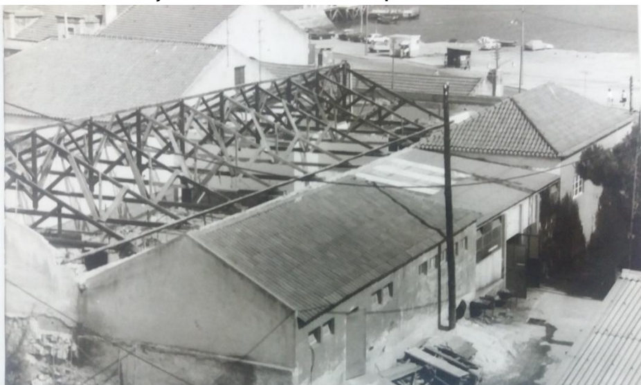
Imagem 33 - Registo fotográfico da construção do Salão Nobre; Fonte: Arquivo da Sociedade União Seixalense; Data: 1967
