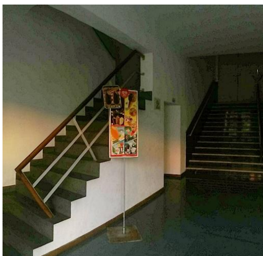
Imagem 4 - Entrada principal - escadas de acesso ao piso 1 e, ao fundo, escadas de acesso ao piso intermédio. Fotografia de Andreia Antunes
