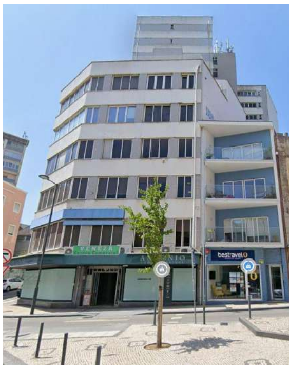
Figura 3 - Vista Principal da Entrada Principal do Edifício. Fonte: Google Maps, 2025
