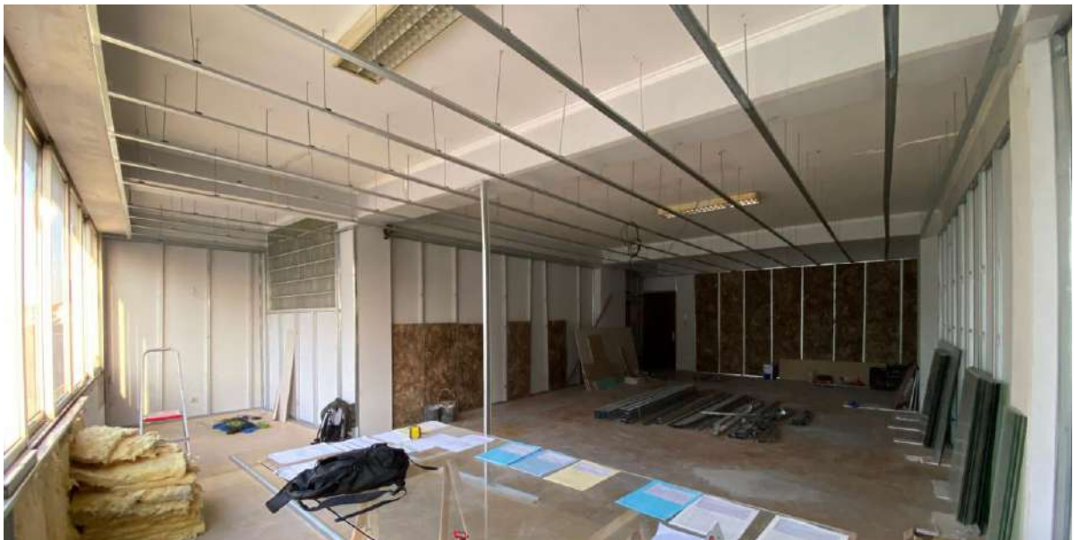
Figura 46 - Fotografia Diurna do Espaço com divisórias removidas. Fonte: Autor do Relatório, 2026
