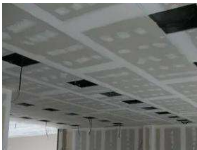
Figura 18 - Tubulações de Teto Falso. Fonte: cableado estruturado sase, 2026
