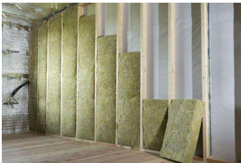
Figura 26 - isolamento acústico em lã de rocha. Fonte: Casa e Obra, 2026
