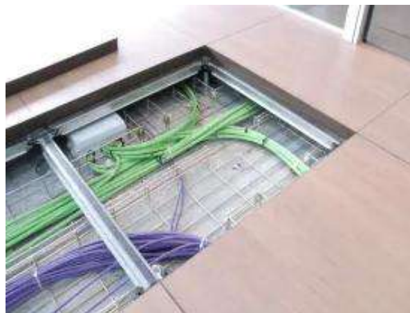
Figura 19 - Tubulações subterrâneas. Fonte: cableado estruturado sase, 2026
