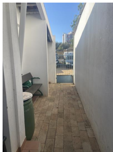
Figura 20 – Corredor Exterior que dá acesso garagem, Telheiros e arrumos.
