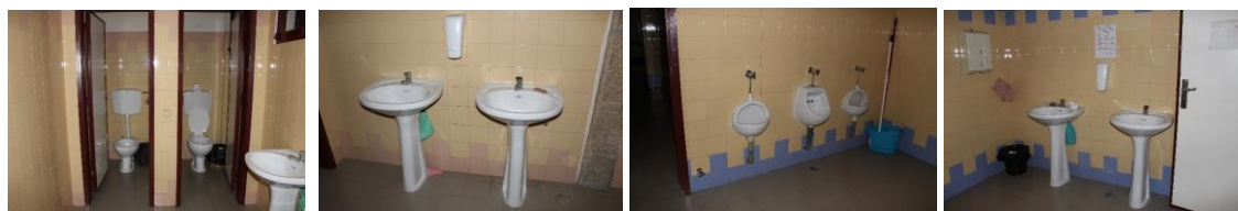
Figuras 20, 21, 22 e 23 - Casas de Banho do Pavilhão A
