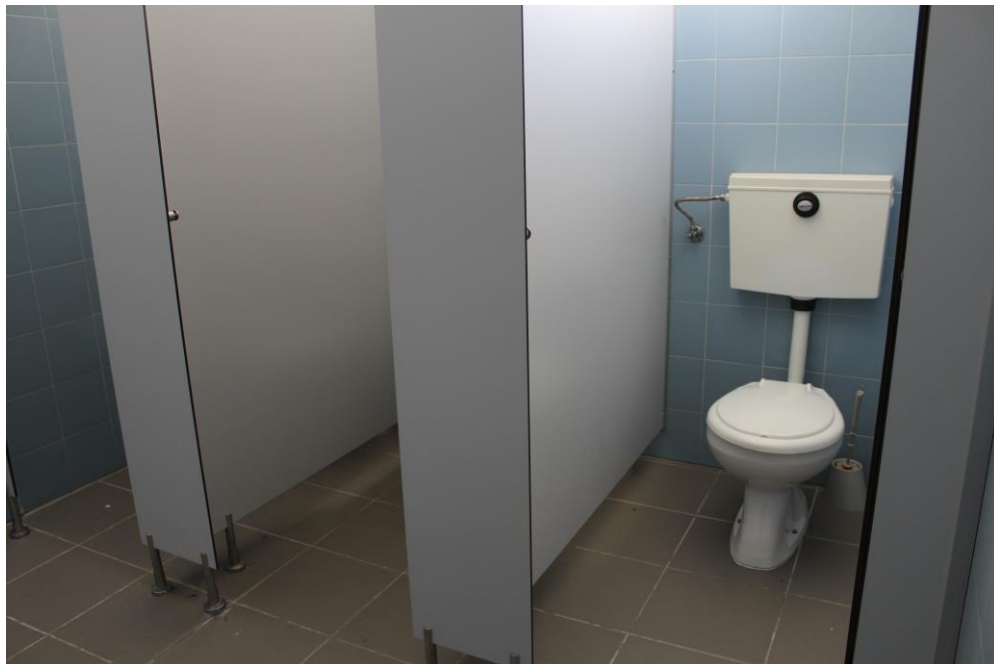
Figura23– Zona traseira do edifício B
