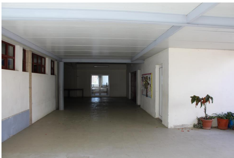
Figura20– Zona traseira do edifício A
