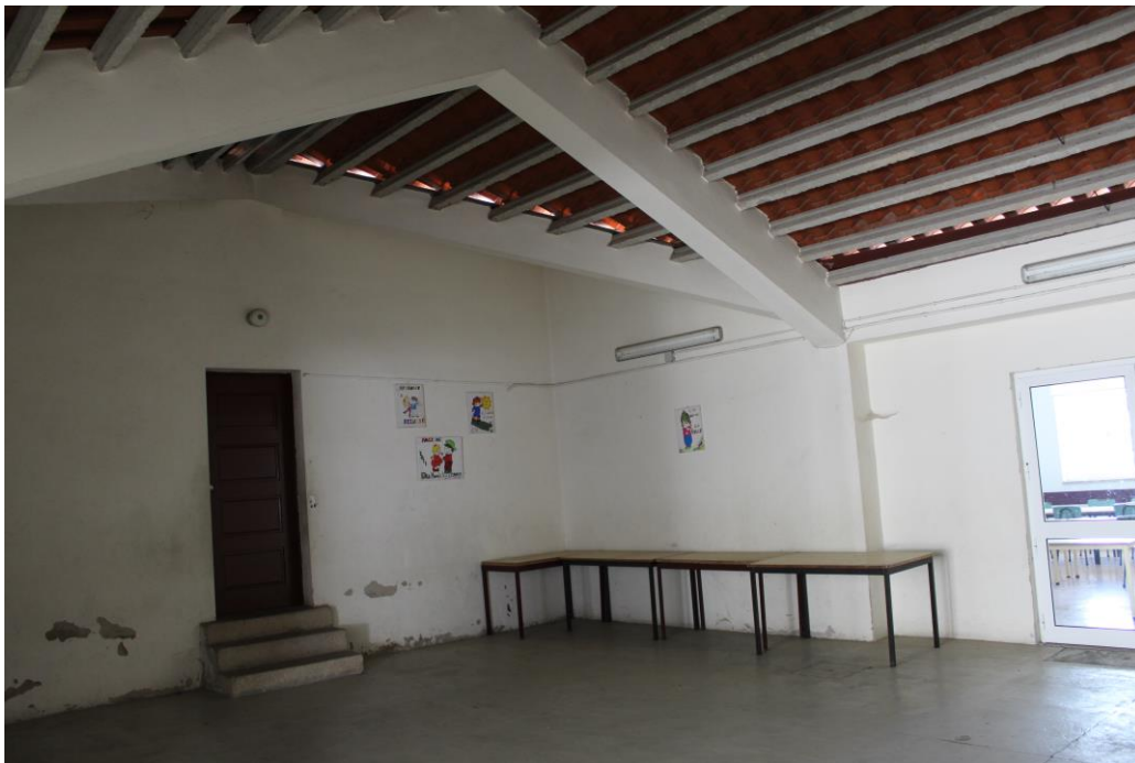
Figura19– Zona traseira do edifício A
