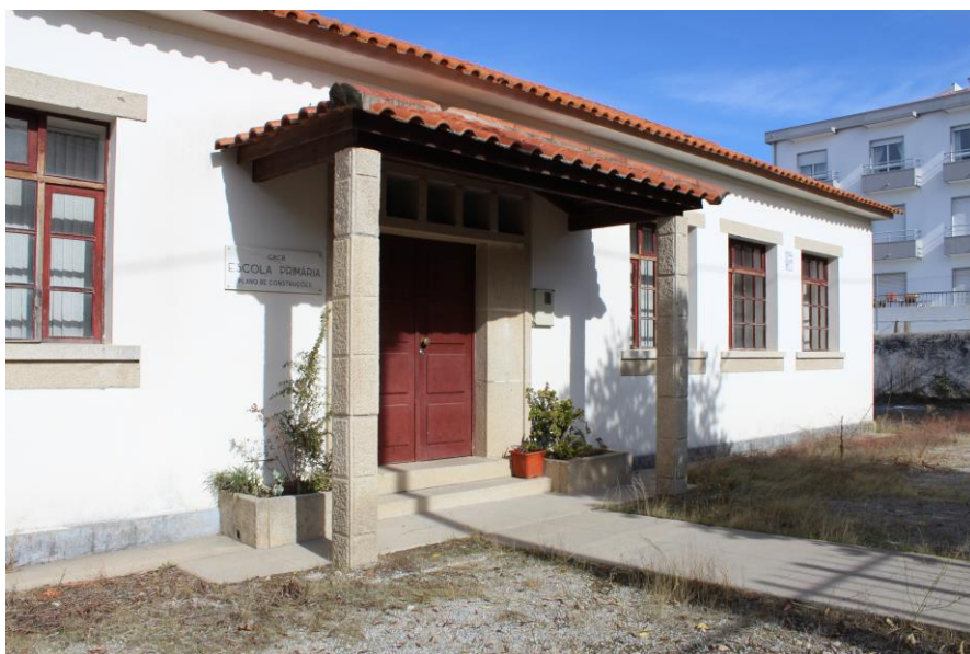
Figura27 – Fachada dos edificios
