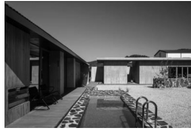
Figura 79 - Zona exterior – edifício B. Fonte: Hong Kiwoong.
