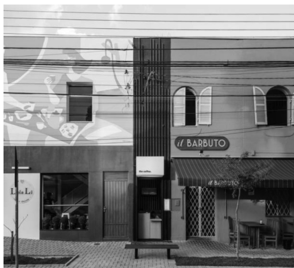
Figura 91 - Exterior do “The Coffe” e a sua envolvente. Fonte: Eduardo Macarios.
