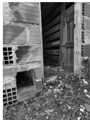
Figura 165 - Pormenor ampliado do pavimento. Fonte: Adriana Tomás.
