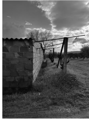
Figura 162 - Estado atual da fachada posterior da habitação 1. Fonte: Adriana Tomás.
