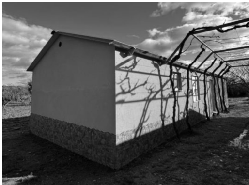
Figura 26 - Fachada este e norte, respetivamente. Fonte: Adriana Tomás.
