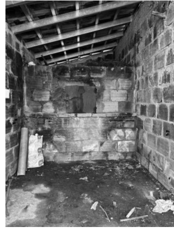
Figura 163 - Estado atual da zona do forno, pertencente à habitação 1. Fonte: Adriana Tomás.
