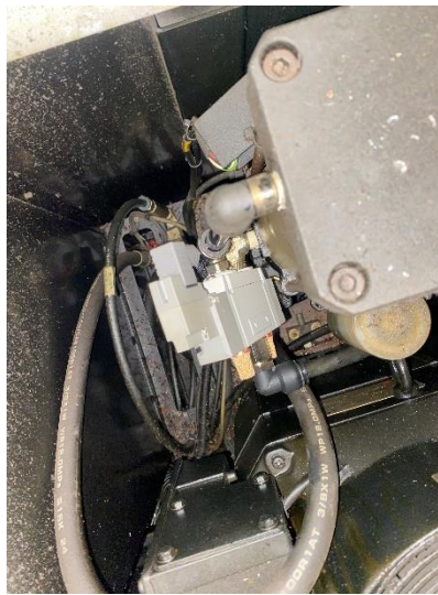
Figura 24 - Electroválvula nova já montada
