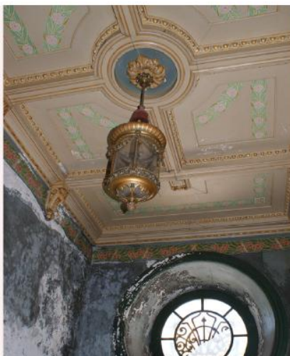
Figura 5- Pormenor do teto em masseira, fotografia da Mónica Romãozinho.
