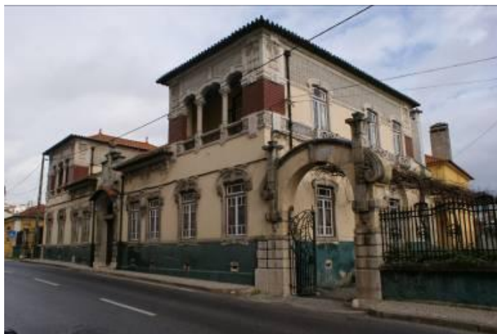
Figura 2- Fotografia da fachada da casa d'Arrabalde
