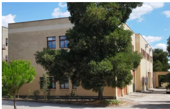
Figura 20 - Bloco C da Escola Superior de Tecnologia de Castelo Branco.
