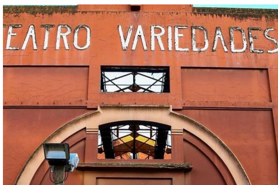
Figura 12 - Patologia na cobertura Fonte: RUIN'ART
