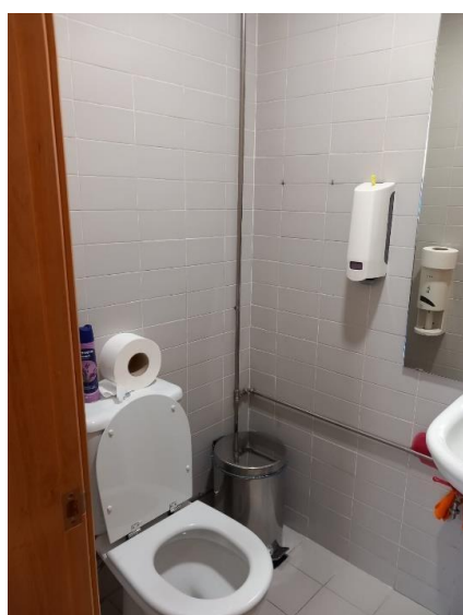
Figura 15. Wc feminino - vista 1. Fonte: Autor
