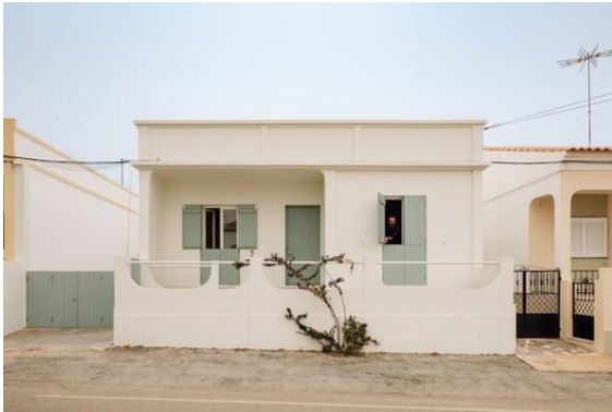
Figura 34- Exterior da habitação depois da reforma Fonte: Francisco Nogueira
