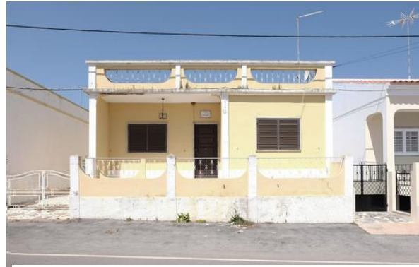
Figura 35- Exterior da habitação antes da reforma Fonte: Francisco Nogueira
