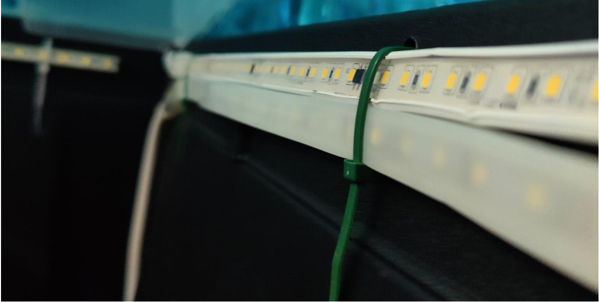
Figura 46 - Perfuração para instalação de braçadeiras para as fitas LED
