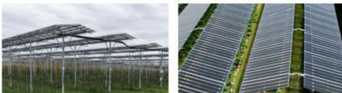
Figura 10 - Estrutura montado em estacas com painel FV semitransparente. Fonte: RES4Africa Foundation (2023).
