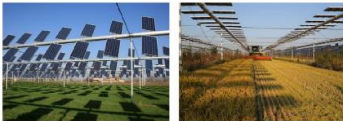
Figura 8 - Estrutura montada em estacas com sistema de rastreamento de 2 eixos. Fonte: RES4Africa Foundation (2023).
