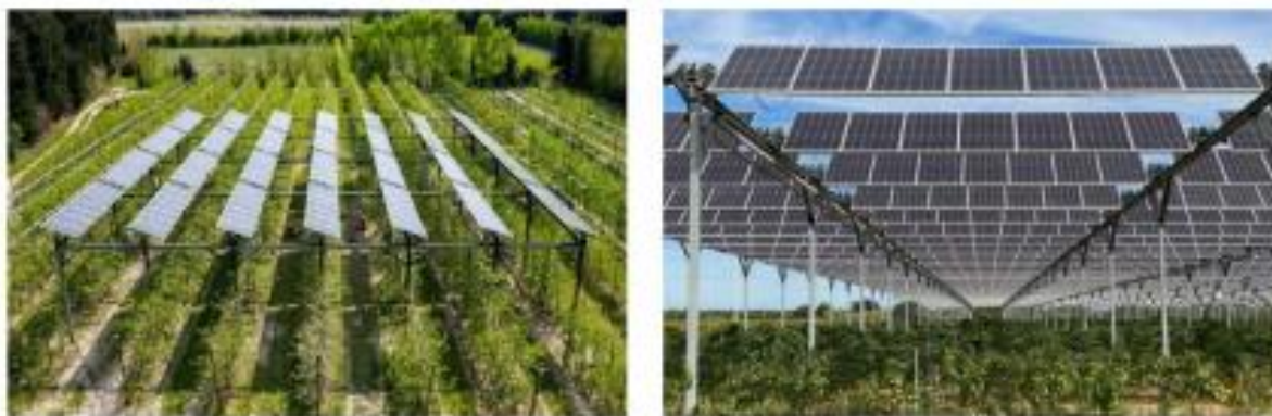
Figura 7 - Estrutura montada em palafitas com sistema de rastreamento de 1 eixo. Fonte: RES4Africa Foundation (2023).
