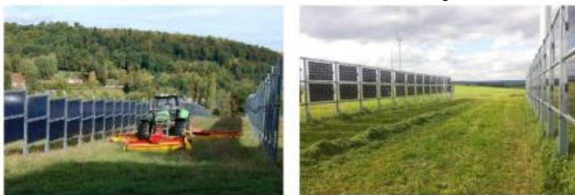
Figura 9 - Estrutura com paredes verticais. Fonte: RES4Africa Foundation (2023).
