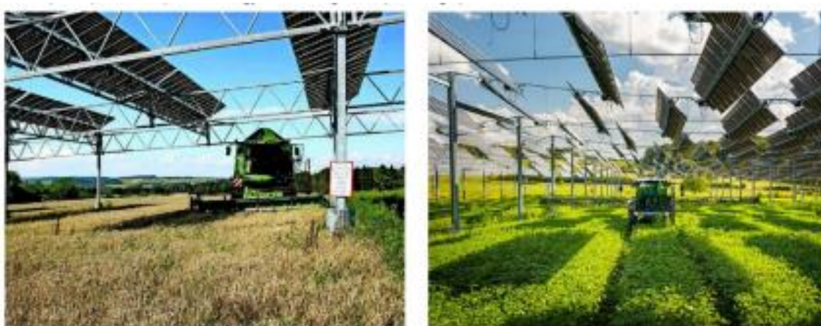
Figura 5 - Estrutura montada em estacas com painéis FV inclinados em ângulo fixo Fonte: RES4Africa Foundation (2023).
